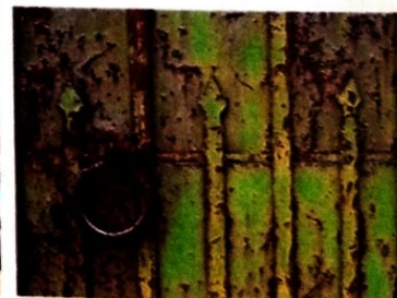
Fig. 23 – A porta de ferro está enferrujada por causa do oxigénio que existe na água e no ar húmido.
