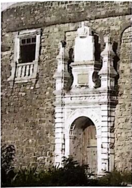
[21] Portal da Fortaleza de São Sebastião, na Ilha de Moçambique.
