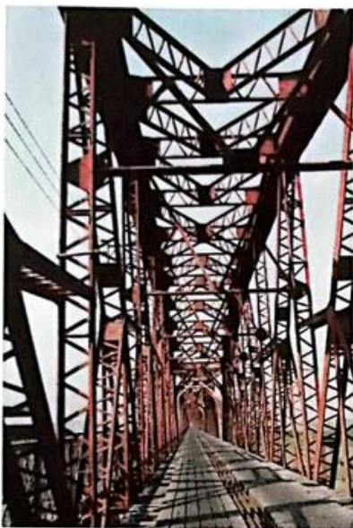
[86] Ponte de Dona Ana, província de Tete. Uma ponte construída com capitais britânicos.
