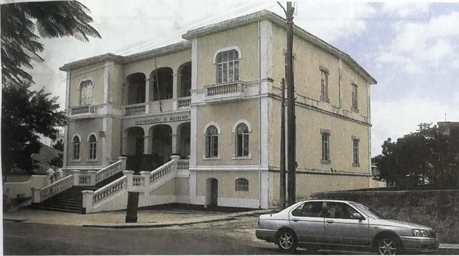
Fig. 33 – Edifício das telecomunicações de Moçambique, em Inhambane.
